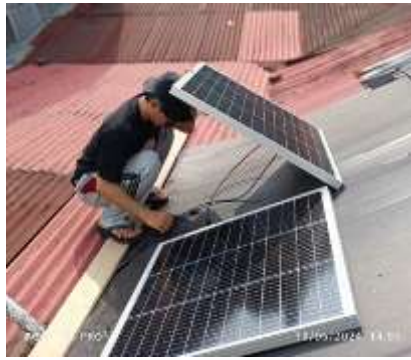
Gambar 3. Pemasangan panel surya di atap rumah produksi
