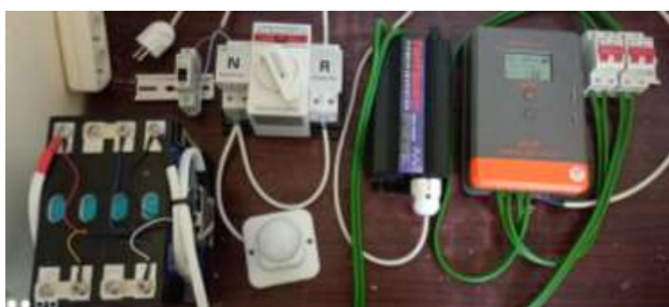
Gambar 2. Hasil pemasangan sistem PLTS
