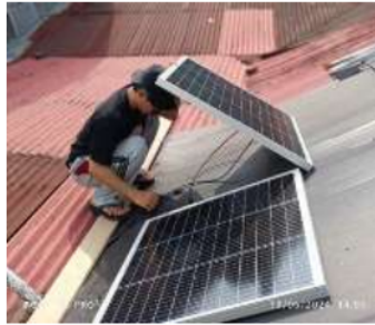
Gambar 3. Pemasangan panel surya di atap rumah produksi
