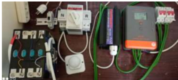
Gambar 2. Hasil pemasangan sistem PLTS
