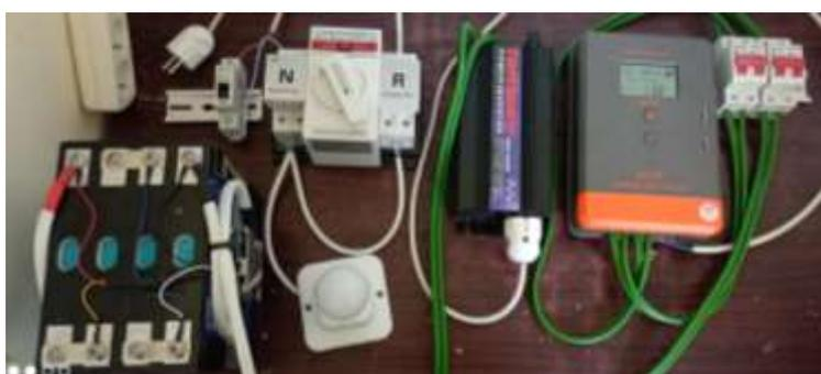
**Gambar 2.** Hasil pemasangan sistem PLTS
