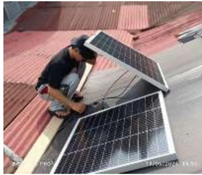
**Gambar 3.** Pemasangan panel surya di atap rumah produksi
